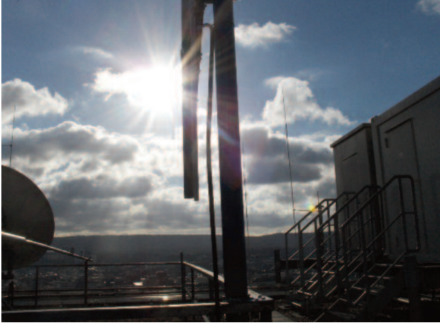
Der Sender auf dem Dach des B-Gebäudes der FH (Foto: FH)
